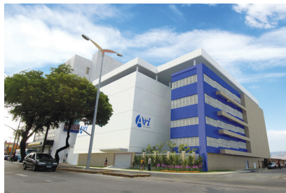
Ari - Major Facundo - Rua Major Facundo, 980, Centro (esquina com a Av. Duque de Caxias) Fone: (85) 3255.2900 (Praça do Carmo)
